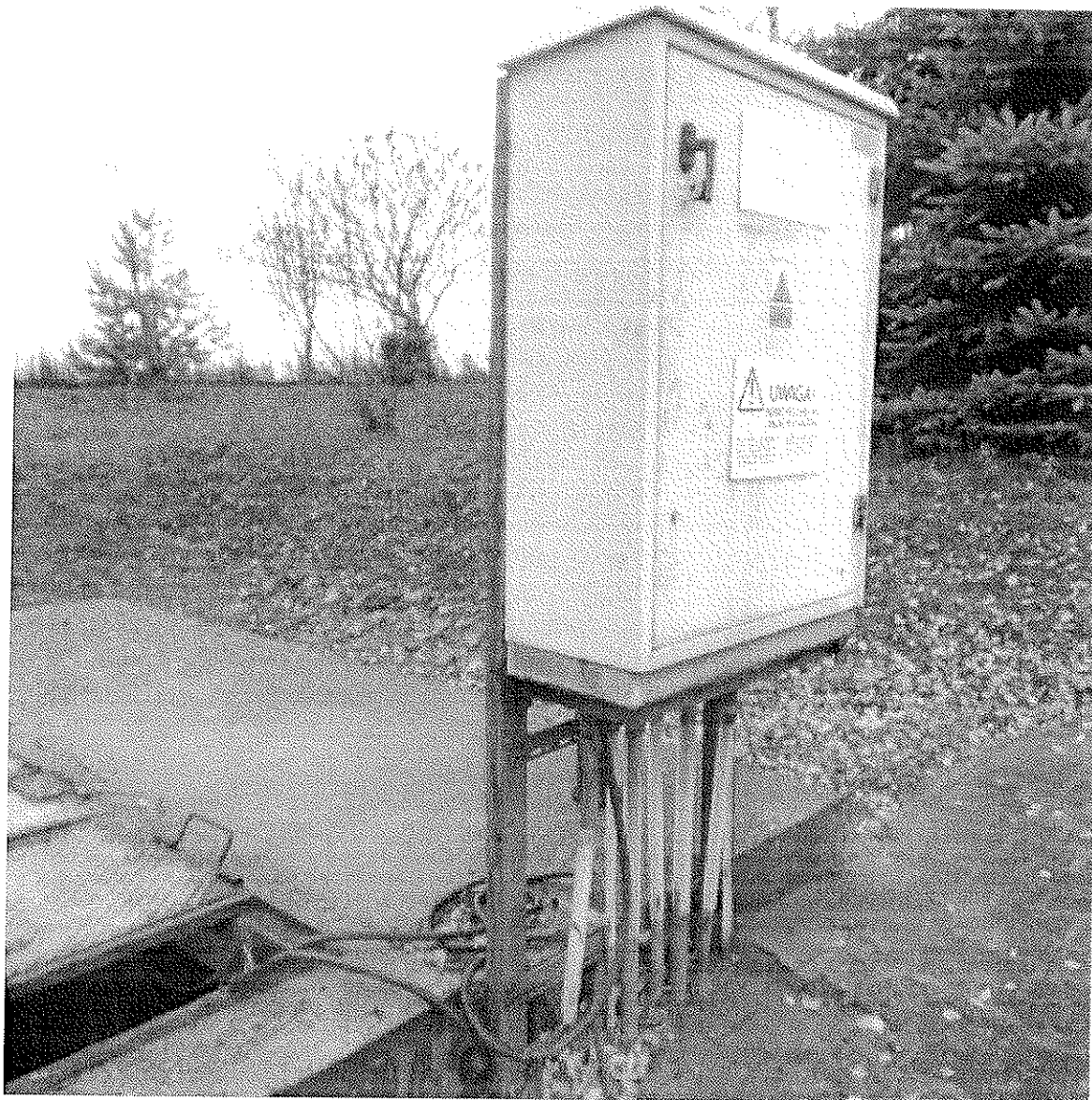
Zdjęcie nr 1 – Istniejąca szafa zasilająco-sterownicza
